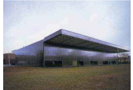
Ricola factory Herzog&Demeuron Basel CH
