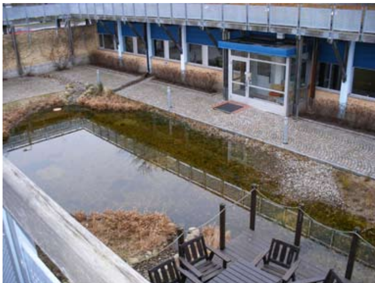
Figure 2.4 Rain gardens, Malmö, Sweden (© Erik van Lennep)
